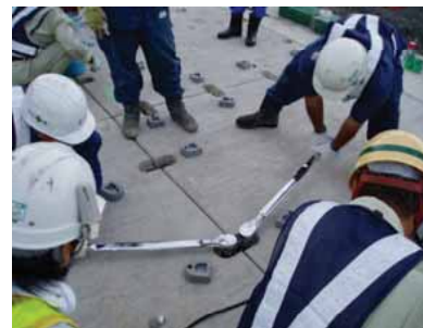
コッター式継手本締付状況
