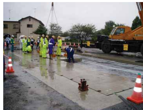
PRC舗装版仮据付状況
