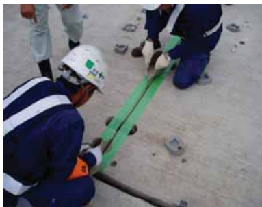
目地部グラウト注入状況
