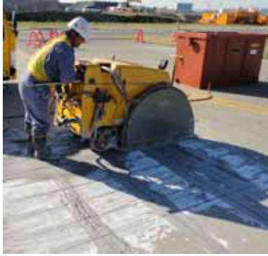
① 舗装版切り出し作業
