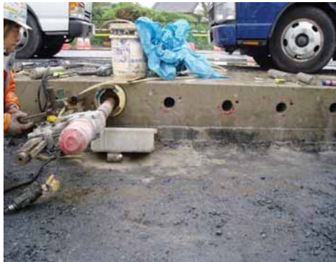
既設NC舗装版削孔状況
