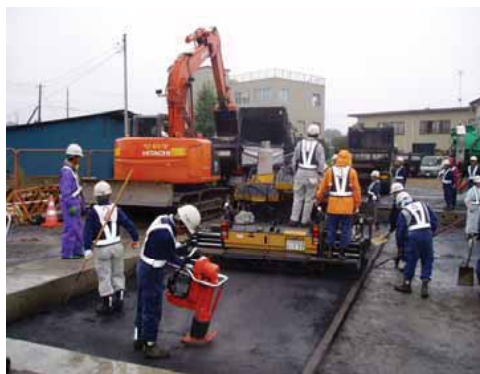
路盤整正状況
