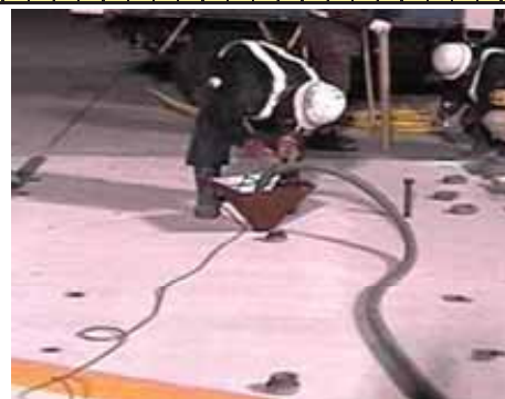
裏込グラウト注入状況
