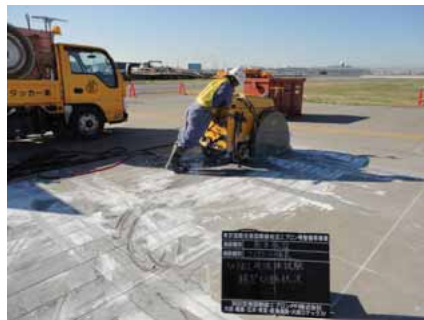
既設NC舗装版切断状況
