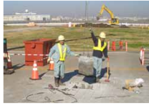
② 舗装版吊り出し作業
