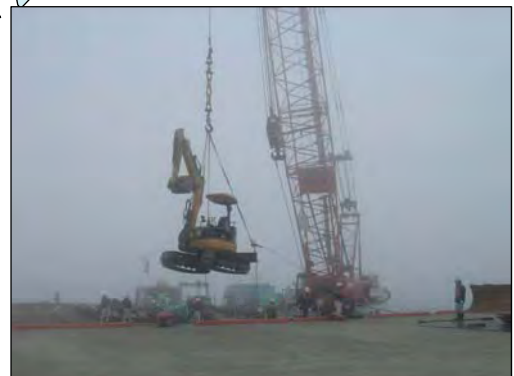
クレーン付台船による重機の陸揚げ(H22.2.25 防災訓練より)
