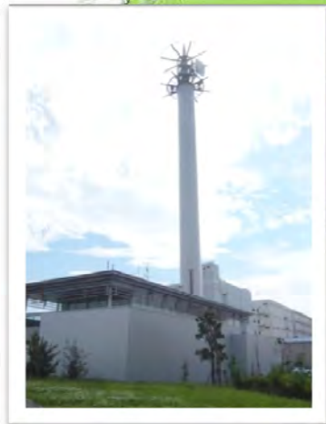
東扇島基幹的広域防災拠点施設 (内閣府物流コントロールセンター)
