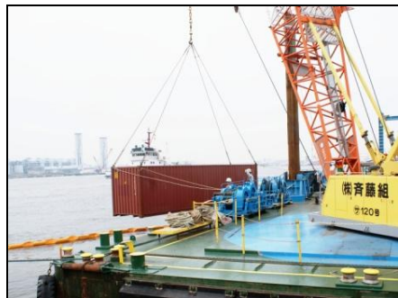
緊急確保航路啓開①
