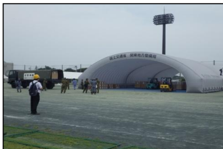
エアテント設置
