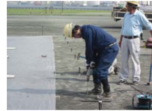
張網を固定しますベグを所定の位置に打ち込む
