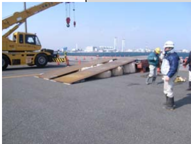
陥没して車両が不通範囲の復旧作業②
