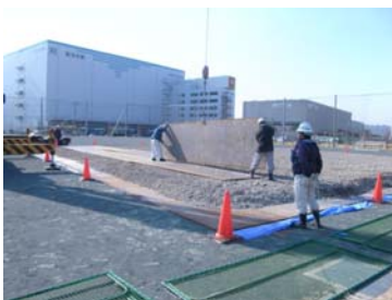
液状化した地盤を整地後、敷鉄板を敷設
