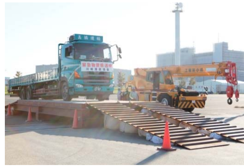
◆仮設橋梁を設置し、輸送ルートを確認(東扇島)
