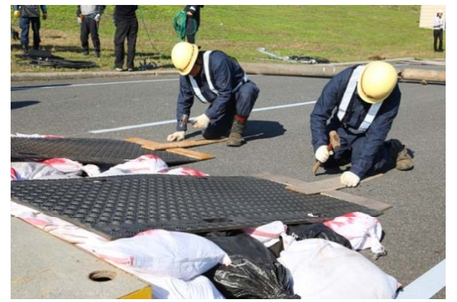
◆土のうの積み上げ等による橋梁段差を解消する訓練
