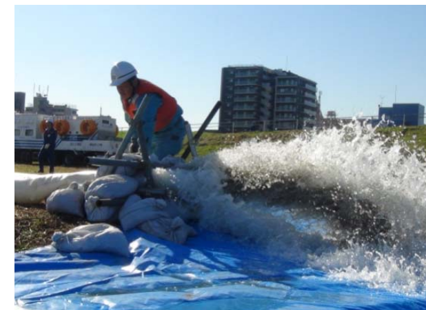
◆排水ポンプ車による排水
