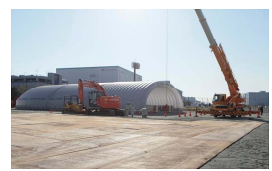
◆液状化した地盤の応急復旧訓練(東扇島)
