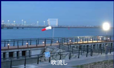
ヘリポートに設置された航空灯火
