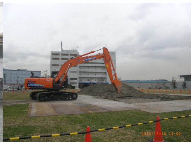
荷捌き地応急復旧① （芝生の地下に埋設してある応急復旧用の 碎石を掘り出す）
