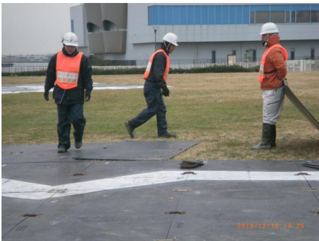
芝生エリアにヘリコプターの臨時駐機スポット 5ヶ所を設置
