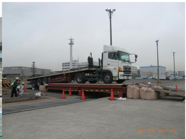
岸壁応急復旧 (仮設橋設置) (耐震強化岸壁の背後が陥没したことを想定 して備蓄してある鋼材により仮設の橋を設置)
