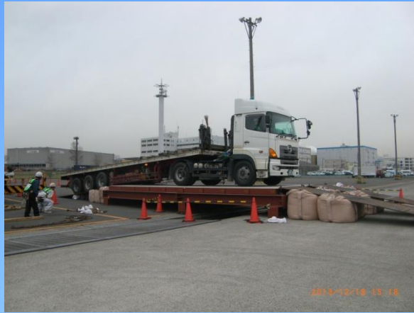
耐震強化岸壁背後の被災を想定した仮設橋設置訓練
