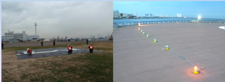
ヘリコプターによる人員輸送や緊急物資輸送のための臨時駐機スポット設置(5機分)及び航空灯火設置訓練
