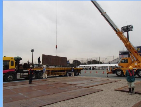
敷地内の液状化を想定した備蓄砕石と敷鉄板による応急復旧訓練
