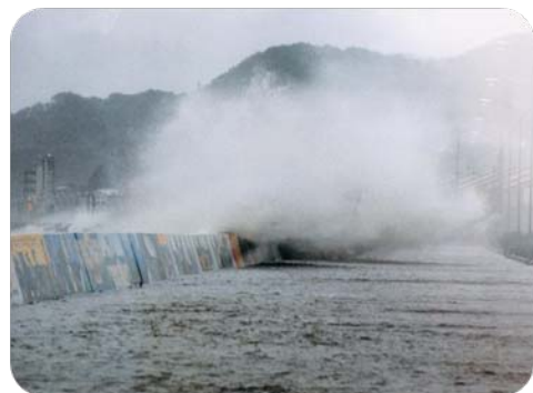
【台風による越波状況】
