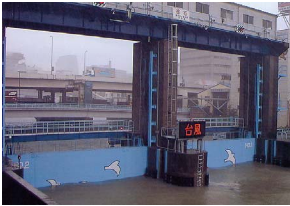
台風による高潮災害を未然に防ぐ東京港高浜水門閉鎖時の様子
